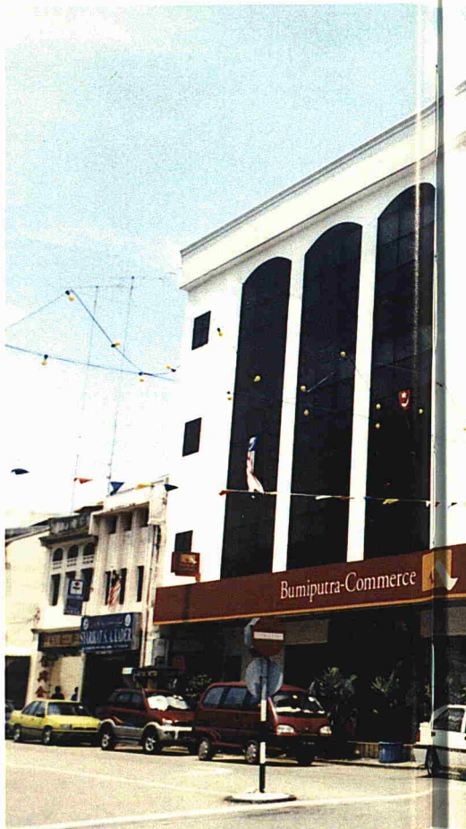
Bangunan Tun Sulaiman dibina pada tapak kedai lama, No 24, Jalan Maharani, Muar.
